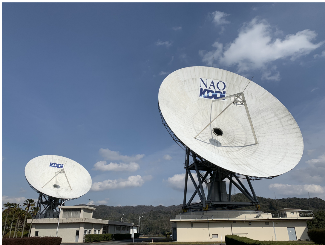
図 8.3.1: 山口大学が運用する山口干涉計。右手前の口径 32m 電波望遠鏡および左奥の口径 34m 電波望遠鏡の 2 基からなる電波干涉計である。
